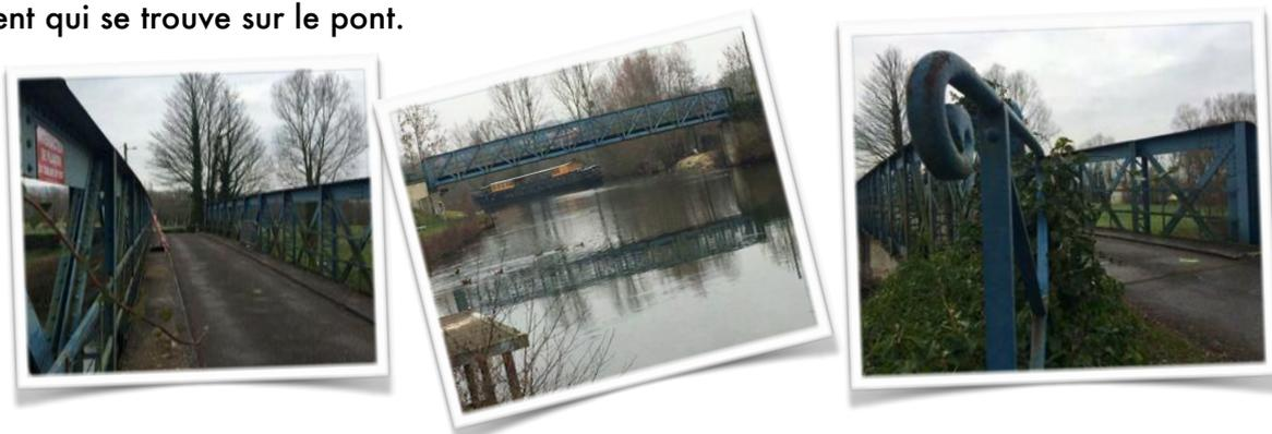
Face à cette situation, nous avons réduit le tonnage des véhicules qui empruntent le pont, désormais limité à 8 tonnes. Des travaux de consolidation du tablier ont été réalisés, grâce aux assurances de ceux qui avaient endommagé le pont avec des engins surdimensionnés pour ce genre de structure.
